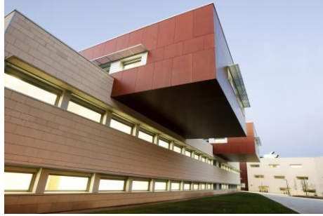
Edificio Científico Tecnológico del campus de la Universidad de La Rioja
